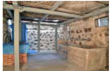
写真11 基礎工事後の地下室内部
