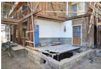
写真3 台所、軸組解体後の様子
