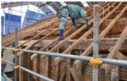
写真 15 垂木組み付けの様子
