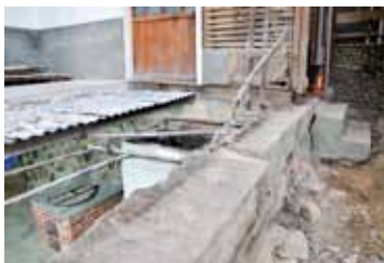
写真4 地下室、配管経路の確認
