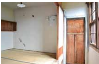
写真 16 修理前の家事室
