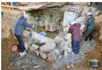
写真5 地下室、基礎石解体の様子
