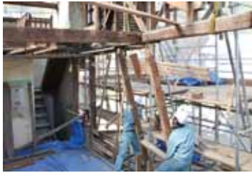
写真2 日本室、軸組解体中の様子
