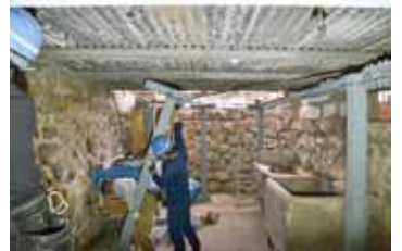
写真9 地下室、補強鉄骨の組立
