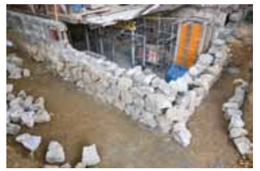
写真8 地下室、基礎石の積み直し
