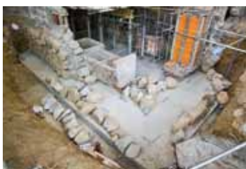
写真7 鉄筋コンクリート製の基礎を打設
