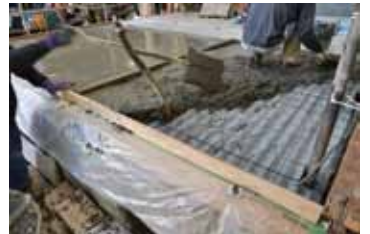
写真12 台所、モルタル床の復旧
