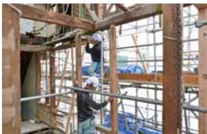
写真 14 日本室、軸組の組み直し
