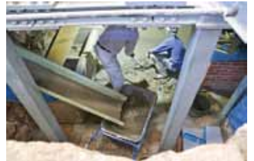
写真10 地下室、モルタル床の復旧
