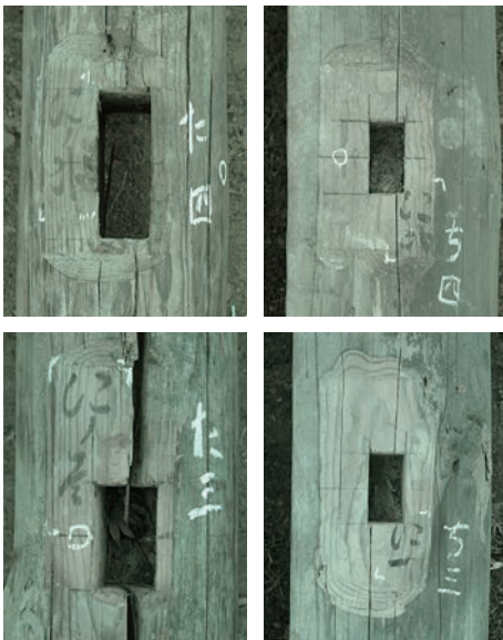
墨書写真(写真3~6) チョークは解体番付 居住部：(右上)「に弐」、(右下)「に一」 役所部：(左上)「にノ弐」、(左下)「にノ壹」
