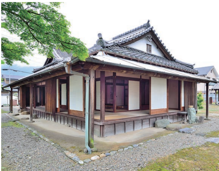
写真1 座敷部を北東からみる 北、東面にはこけら葺き(解体済み)の土庇がつき、室内は開放的な縁が廻る。
