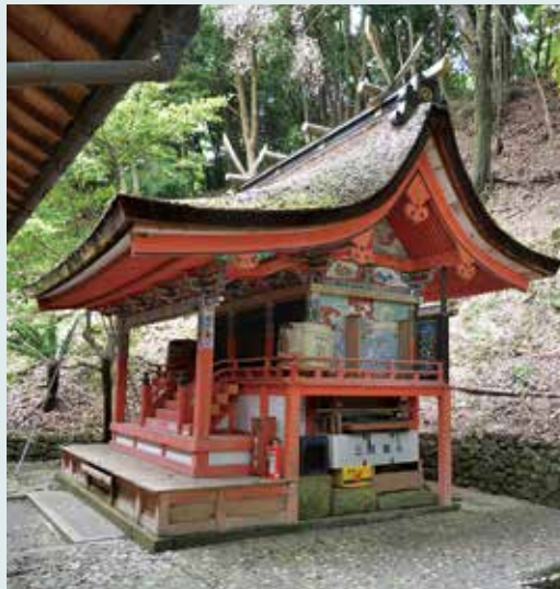
上岩出神社本殿全景
