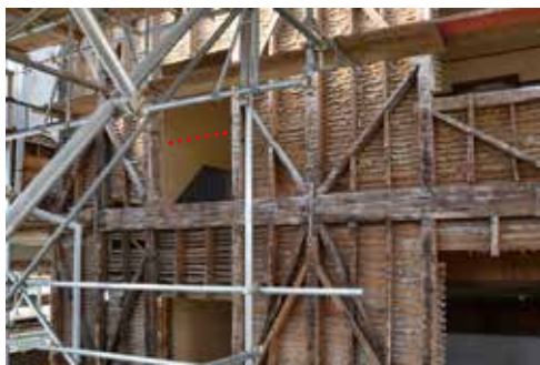
写真7. 切除された窓台（破線部分）
