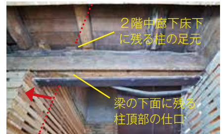
写真10. 内階段まわりの改変痕跡
