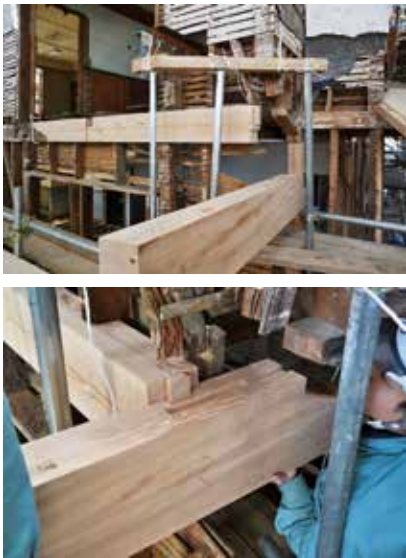
写真1. 主屋南東での軸組補修中の様子 （組み上がった状態が表紙下の写真）
