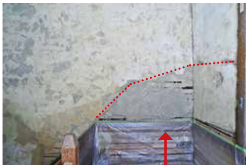
写真7. 切除された窓台（破線部分）
