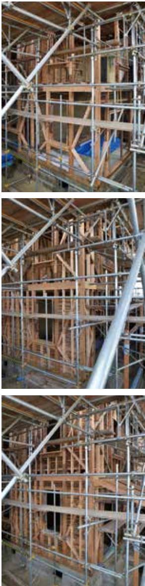
写真4. 主屋北東での施工の様子（上から順に、軸組復旧、壁下地復旧、内壁土塗りの状況）
