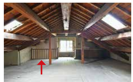
写真9. 主屋の屋根裏（北側を見る） 屋根裏へは左奥の内階段から上ります。
