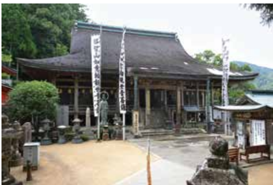
写真1. 修理前の本堂（全景）
