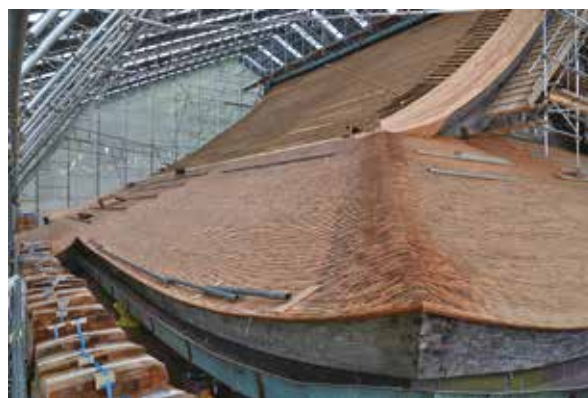
写真8. こけら葺き施工中の屋根面
