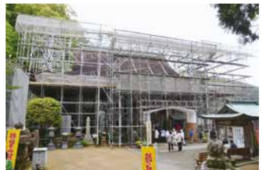
写真3. 素屋根の建設中の様子
