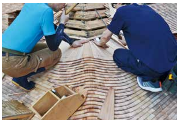
写真7. 隅部分でのこけら葺きの様子
