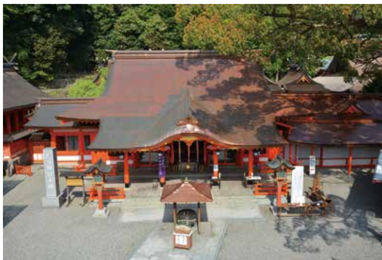
竣工した拝殿
