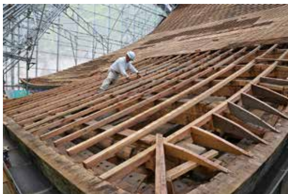
写真6. 向栞での屋根下地補修の様子
