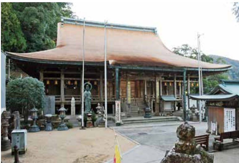
写真4. 修理後の本堂（全景） 写真1と同じ位置から撮影。
