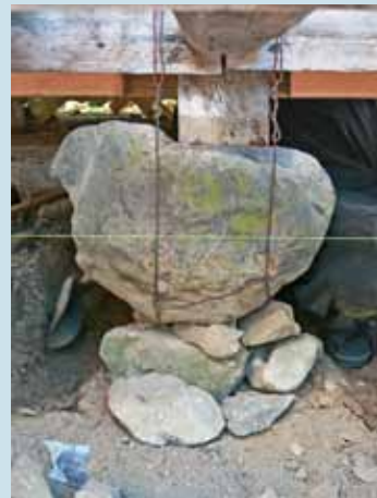
柱に合わせて礎石を据え付け、周りをコンクリートで固めた。
