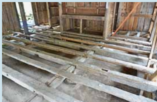
地蔵堂の床組（桁などの転用材が見られる）
