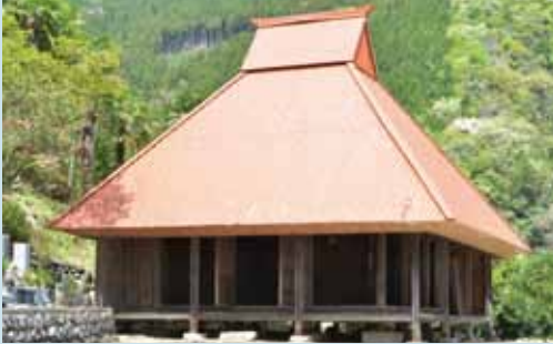
地蔵堂（竣工正面）
