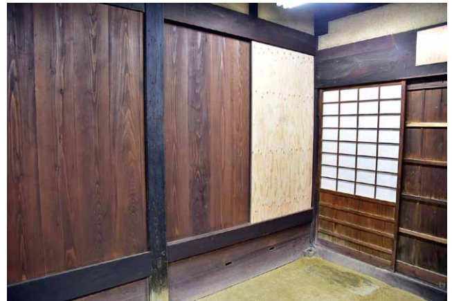
写真8 建具補強、右が構造用合板、左は既存建具
