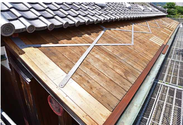
写真13 庇帯鉄補強、屋根面を筋交い状に補強した
