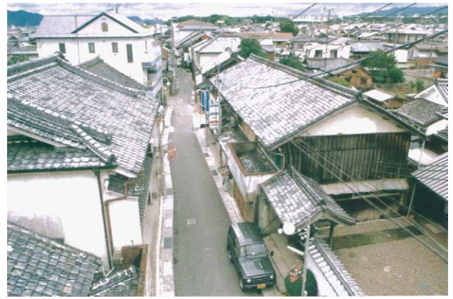
写真1 敷地南側道路（大和街道）を東から見る。 道路の北（右）側に長屋が建ち、右端に下屋が欠き取られた主屋が見える。（平成9年頃撮影）
