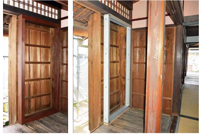
写真6 鉄骨フレーム補強、右はカバー取り付け前
