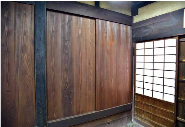
写真9 同右、構造用合板に化粧板を取り付けた状況
