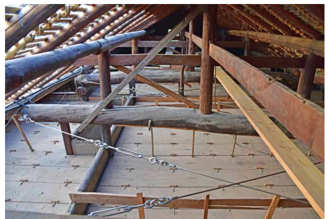
写真12 水平ブレース取付状況
