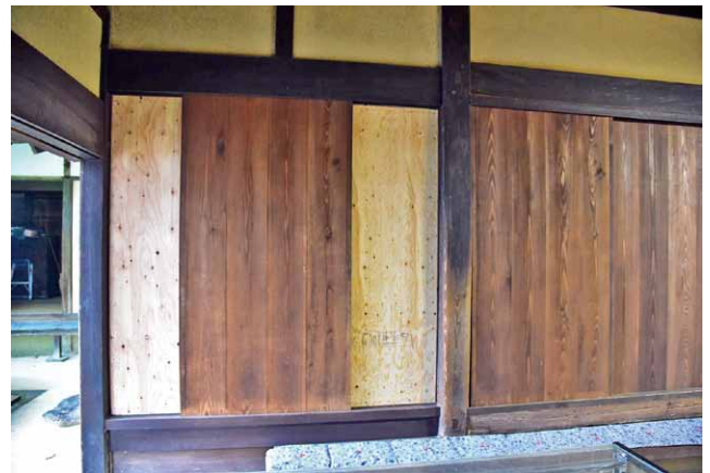
写真10 耐震壁組立状況、真ん中は既存建具
