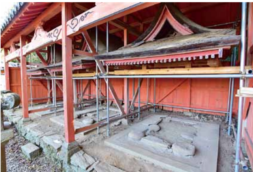
写真3 屋根部分を持ち上げ（揚屋）て軸部を分解した状況 表紙上写真と同位置より撮影
