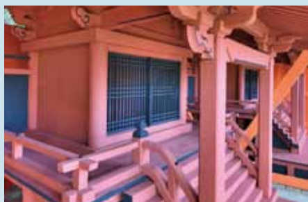
熊野三所権現の正面側（竣工）
