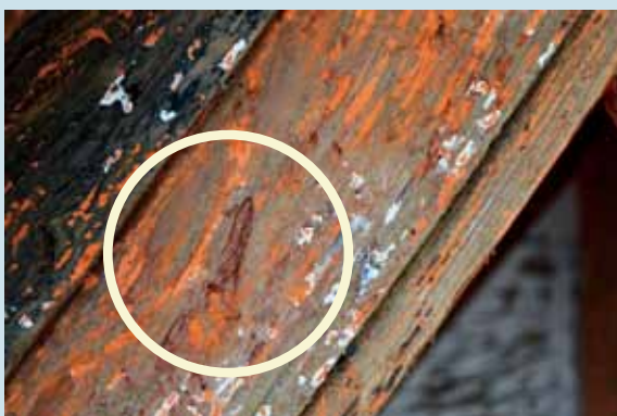
小屋組部材（上）と旧塗装面（下）の痕跡
