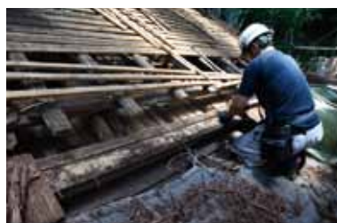
軒付積み替え作業状況（写真2）
