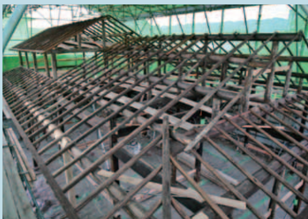
木工事 施工状況（南東からみる）
