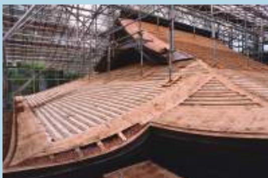
檜皮屋根の解体状況
