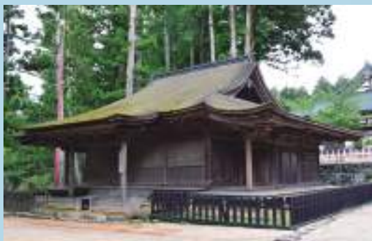
金剛峯寺不動堂 修理前全景
