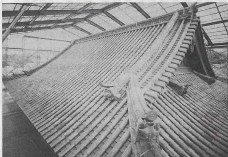
■ 屋根本瓦葺きの完成
