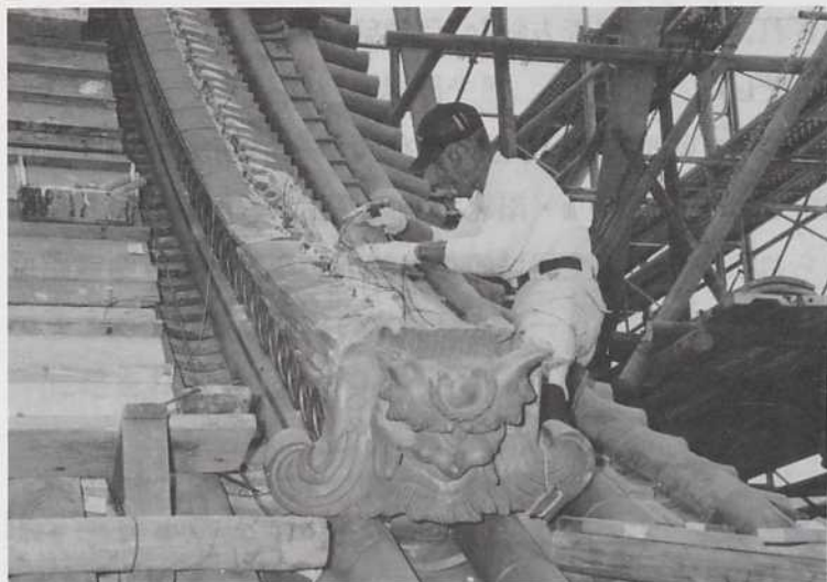
■ 屋根降り棟の棟積みの状況
