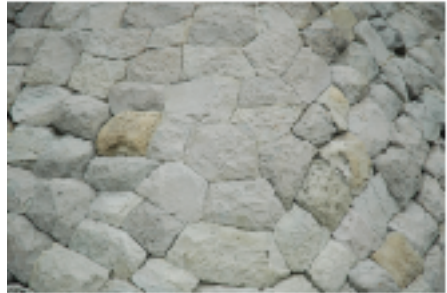
写真2 精緻な切り込みはぎ部
