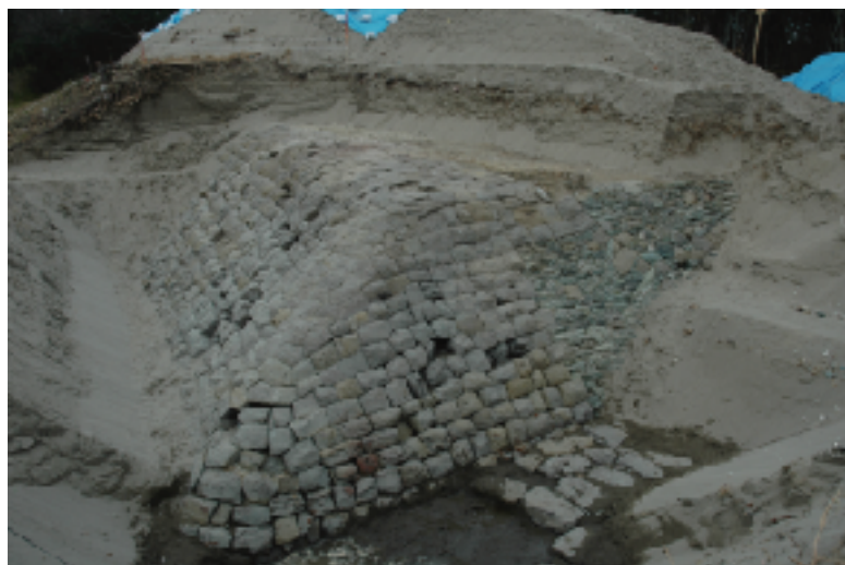
写真6 水軒堤防石堤南端部(南西から)
