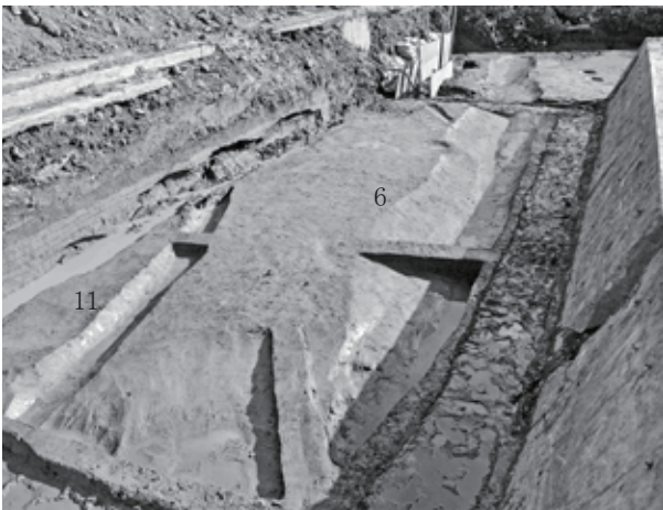
6 井辺遺跡 2010-2 区 6 溝・11 溝・谷状地形(北北西から)
