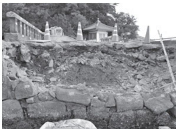
石垣C西土層 西より
