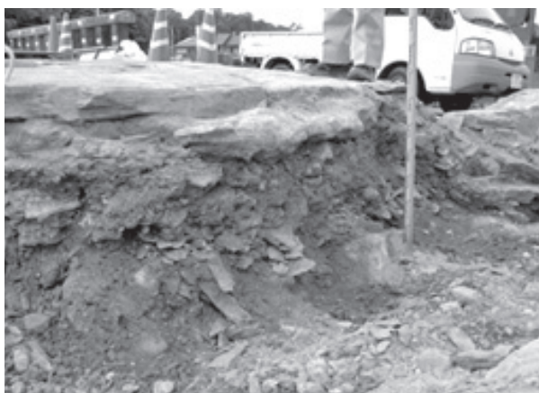
石垣C東土層 南東より
