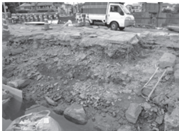
石垣C東土層 南東より
