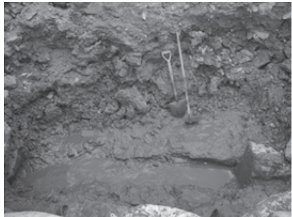
図 20 根石解体状況
