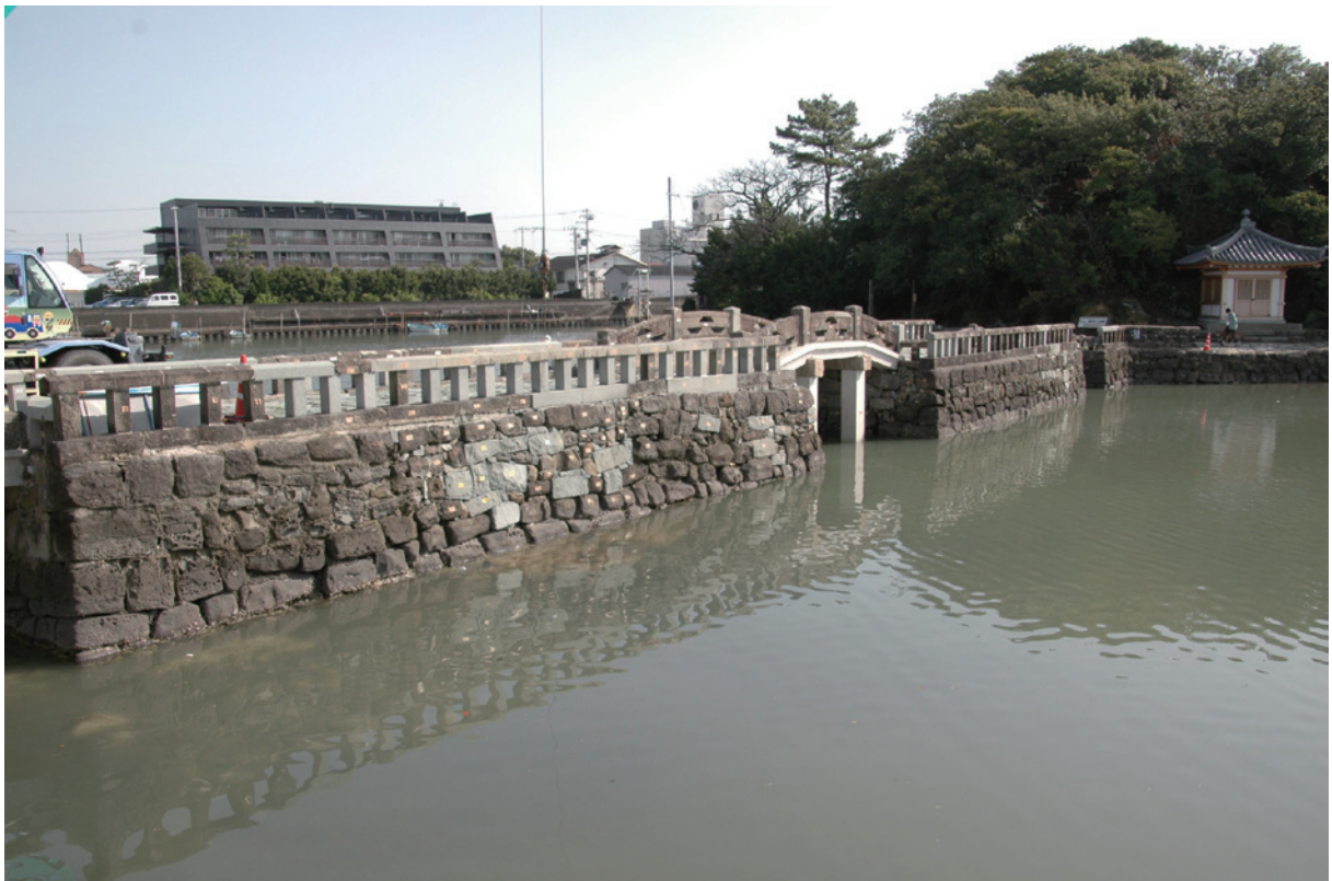
三断橋整備写真
