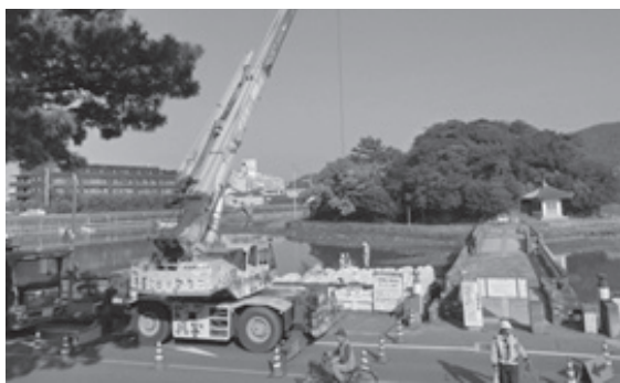
図 14 大型土嚢設置
