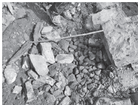
図 55 石垣裏込め石 西石垣・南側
