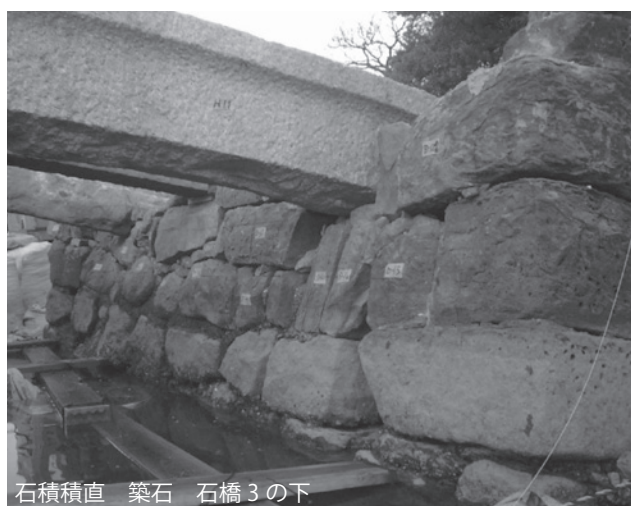
石積積直 築石 石垣 B 北面の根石
