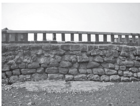
図 54 石垣 B 南岩盤状況
