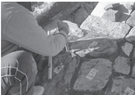
図 22 目地 (二和土入れ)
