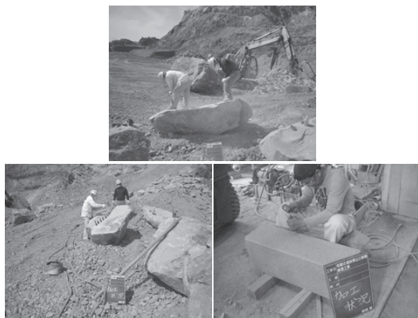
図 29 石の切り出し・仕上げ加工
