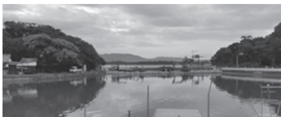
図 13 三断橋北側からの全景
