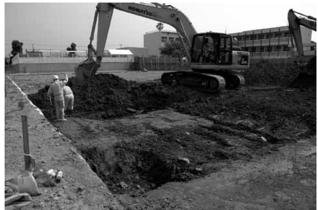
06-3 機械掘削状況（北東から）
