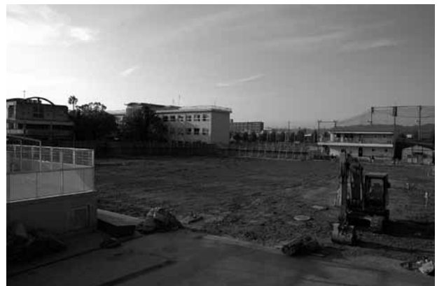
06-5 調査後の埋め戻し状況（南東から）
