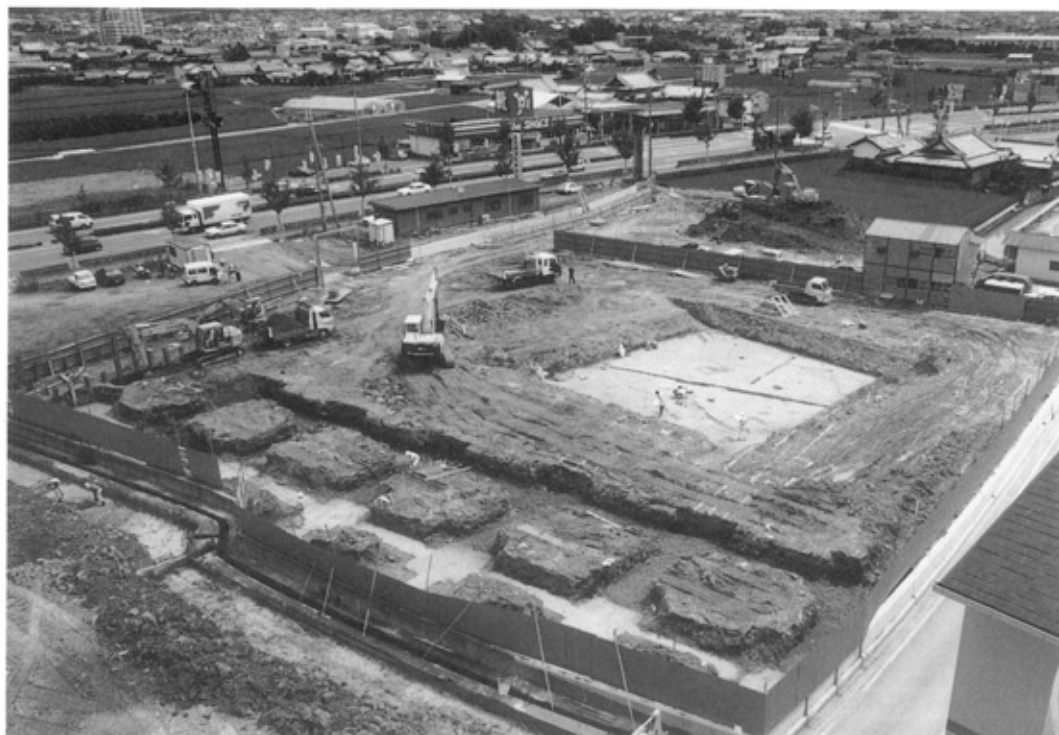
調査地遠景(南西から)
