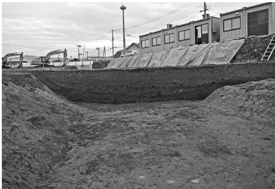
1. 259 堀 断面 (南から)
