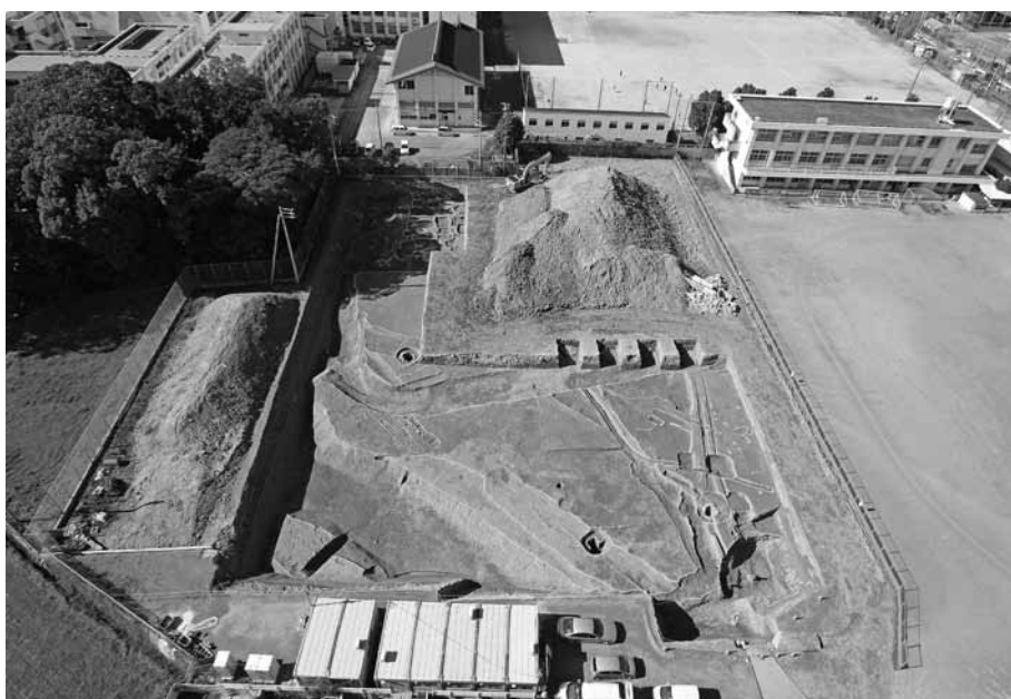
3. 調査区2 (東上空から)
