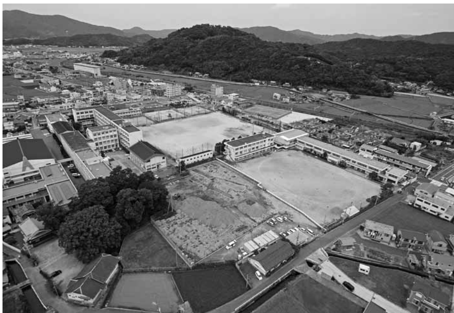
1. 遺跡近景 (南東上空から)
