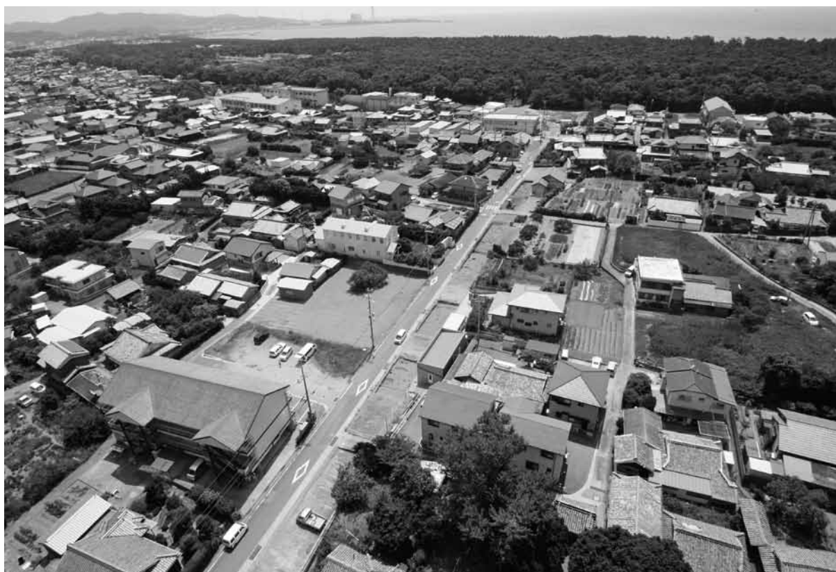
調査地遠景 北西から
