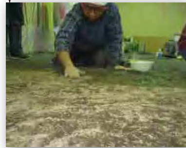
13 地面造形修正 FRP 表面に土が不足している箇所に現地の土を追加して地面を復元。
