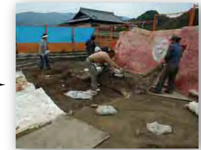
6 剥ぎ取り 竪穴建物からシリコン樹脂を取り外して、建物の表面の土を剥ぎ取り。
