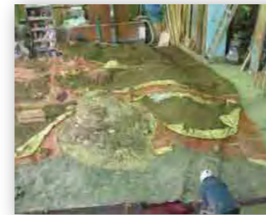
9 樹脂成形 上下反転状態の竪穴建物の土や形状を、再反転するためシリコン樹脂に FRP を敷設して樹脂で成形。
