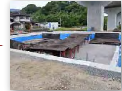
18 部材仮設置 部材を設置坑内に搬入して仮設置。坑内で位置関係を調整。
