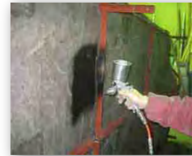
16 裏面塗装 屋外設置に備えて、日光による透過防止のため、裏面を黒色塗装。
