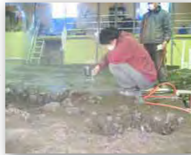
15 表面強化 屋外設置に備えて、表面を樹脂でコーティングすることにより耐久性を強化。
