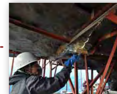
20 接合部裏面強化 仮接合した部材の目地の裏面に FRP をあてがい、樹脂で固定。
