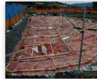
4 型枠補強 FRP の変形防止のために、FRP 補強用の木製の角材を設置して、補強。
