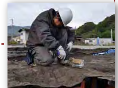
19 部材仮接合 高さ調整も含めた位置関係が確定した部材をビスで仮接合。
