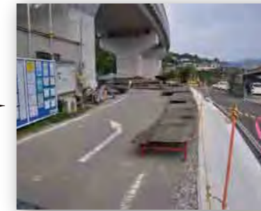
17 運搬・搬入 設置場所まで、FRP 製部材を運搬。設置まで周辺に仮置き。
