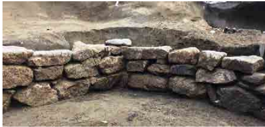
同上石積状況 (室町時代)
