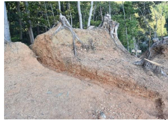
4-2区 北土塁盛土の確認（西南から）
