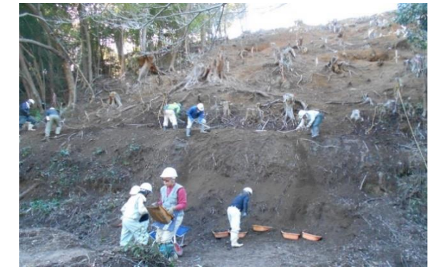
4-1区 東斜面掘削状況（東北から）
