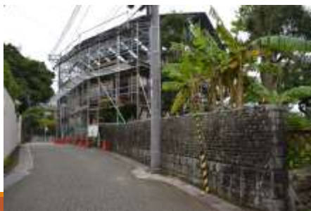
覆屋・足場の設置
