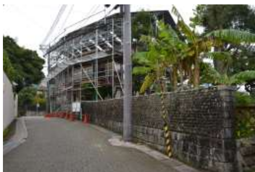
覆屋・足場の設置
