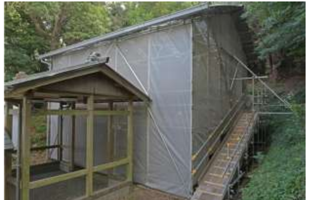
素屋根の仮設
