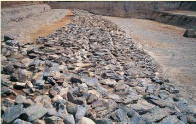
堤防本体の石積み状況
