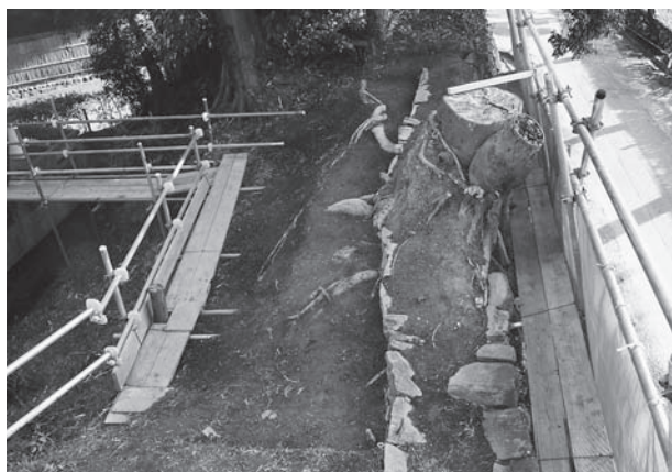
第 1 区全景（北から）
