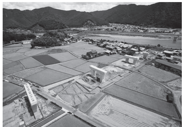
写真1 調査地遠景（南西から）
