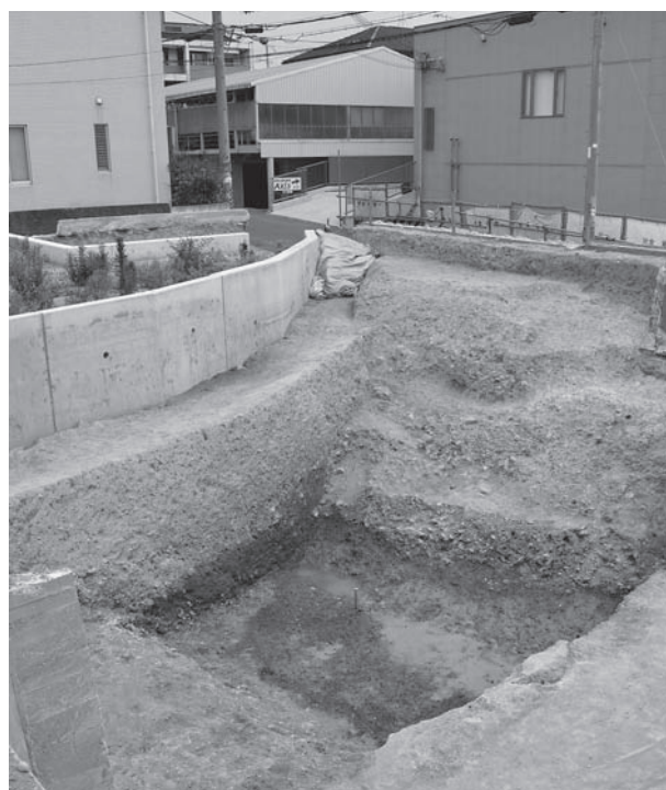
堀状遺構（南西から）
