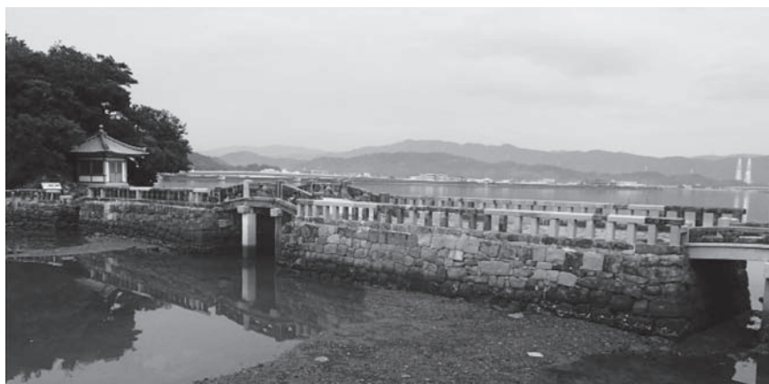
修復された三断橋
