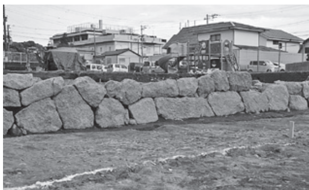
第1遺構面 道路遺構に面する石垣（西から）
