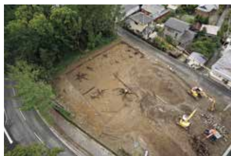
写真2 第2区全景写真（北東から）
