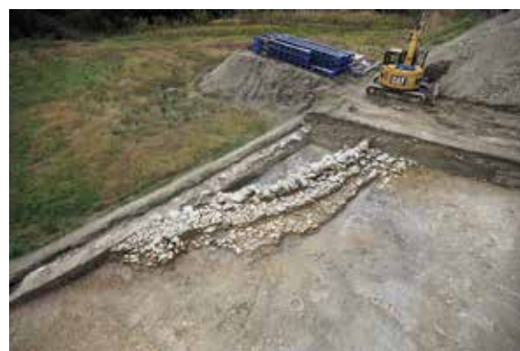
写真4 砂防堤防 北東から
