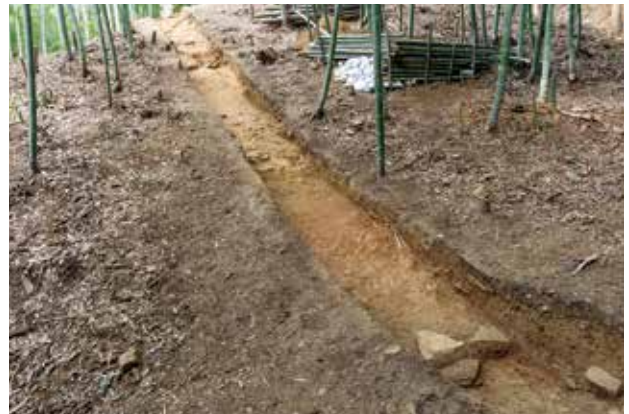
写真11 墳丘側面検出状況（7tr、東から）
