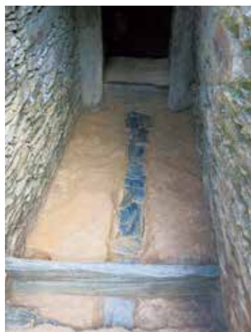
写真2 羨道部排水溝（西から）
