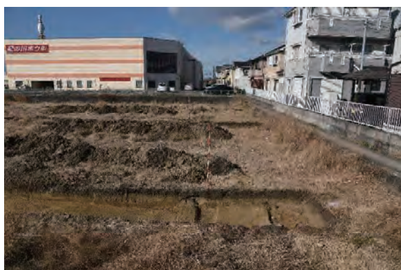
写真1 1・2・3トレンチ掘削状況（東から）
