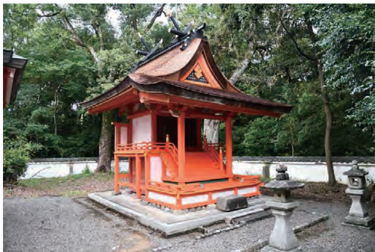
東田中神社境内社 旧竹房神社本殿（保存修理後）
