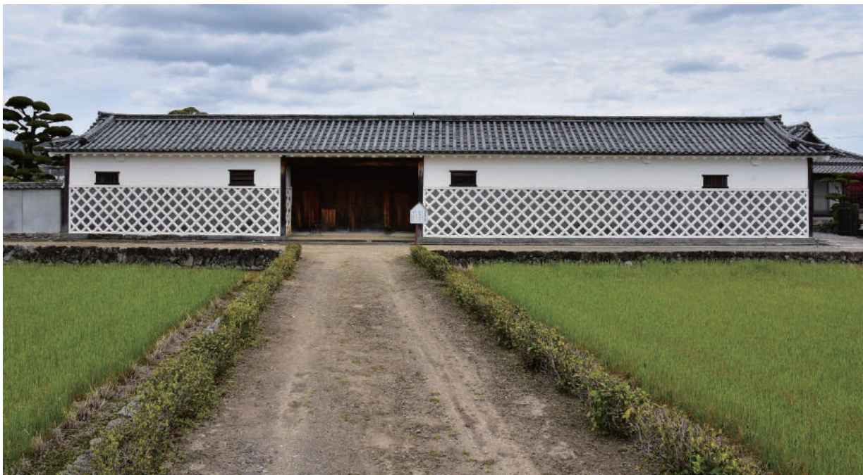
写真1 表門 竣工全景
