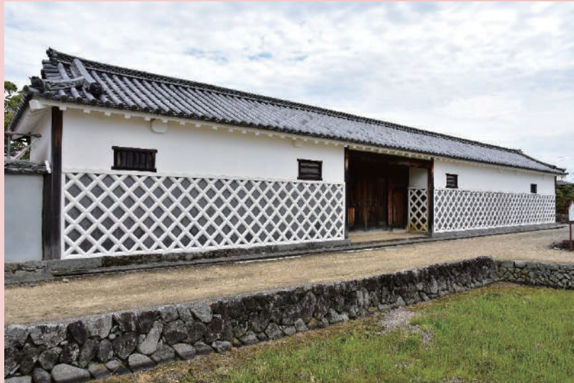
重要文化財 増田家住宅 表門（竣工）
