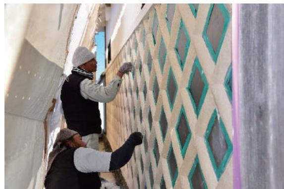
写真3 ナマコ壁の漆喰塗りの施工状況
