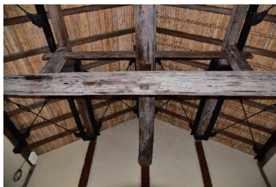
写真4 野地の取り付け鉄骨補強材
