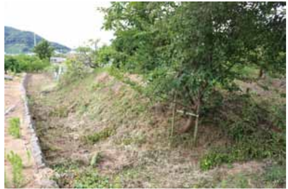
写真5 東堀・土塁（北から）
